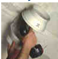
Przymocowanie wspornika
