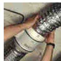
Montaż kanałów wentylacyjnych
