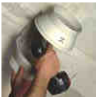
Przymocowanie wspornika
