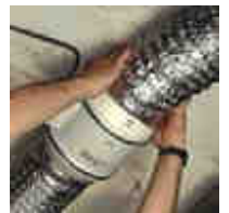
Montaż kanałów wentylacyjnych
