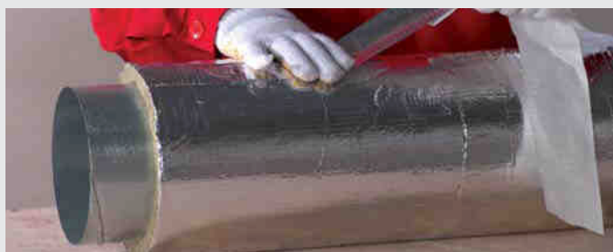
FOT. 411.2. Krok 2 – uszczelnienie taśmą aluminiową połączeń podłużnych i poprzecznych.
