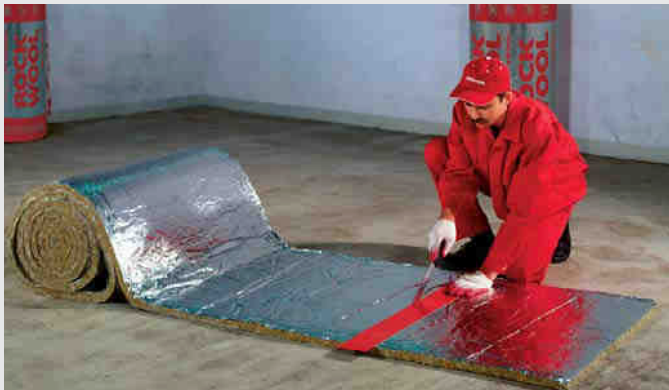
FOT. 411.5. Krok 1 – dokładne zwymiarowanie maty.
