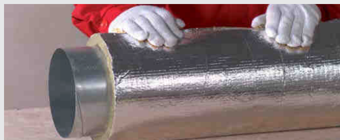
FOT. 411.3. Krok 3 – owinięcie kanału izolacją.
